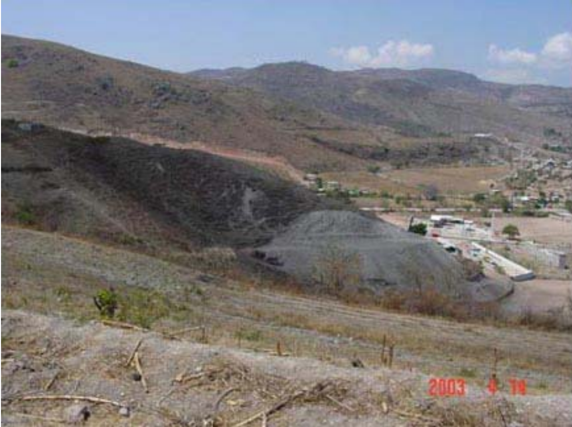
Figura 23. Destrozos en el cerro Xaxalla (CZ-055).
