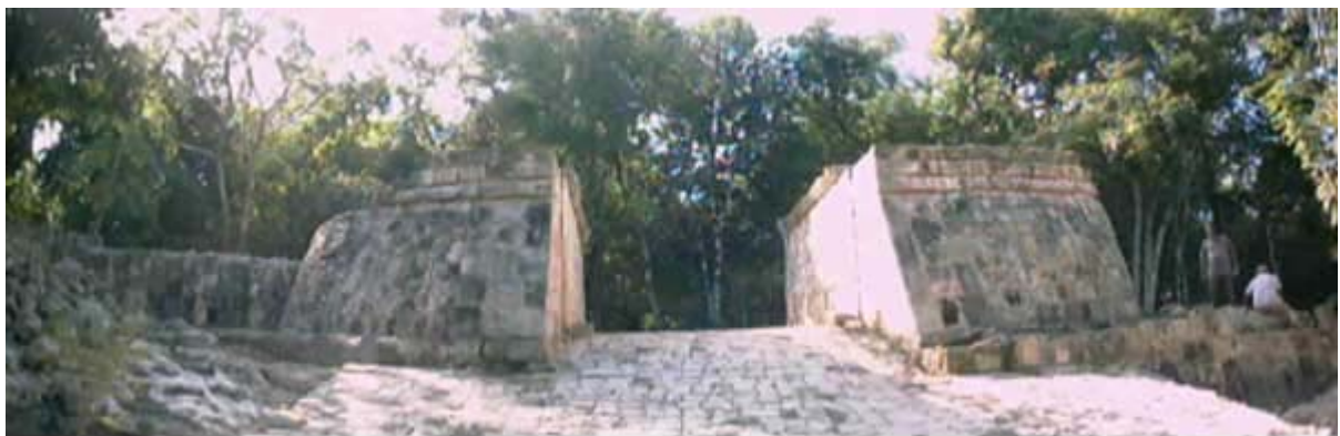
Figura 3. Estructura 5C35, fachada norte.
