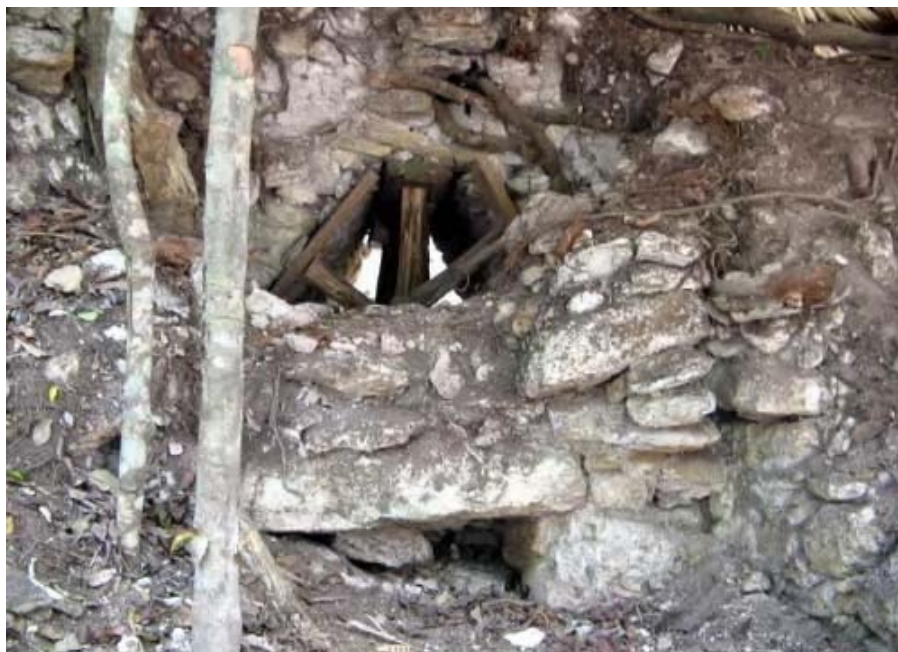
Figura 21b. Pasillo abovedado B-14A.
