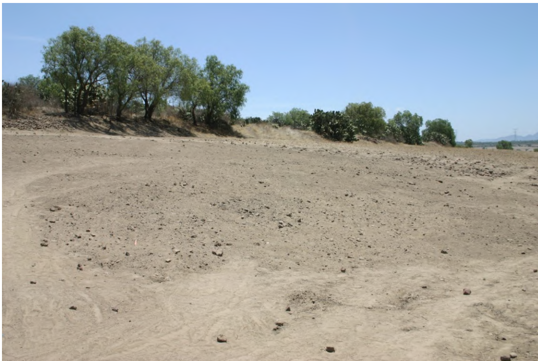
Foto 24. Cierre de la excavación.
