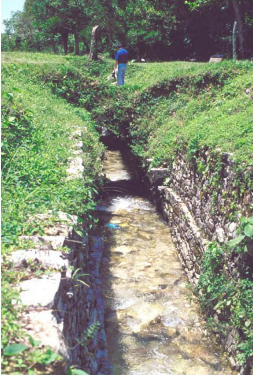
Figura 4. Sección arruinada de acueducto.
