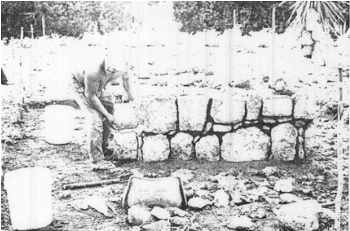
Figura 125. Estructura 2A22, restauración del lado oeste.
