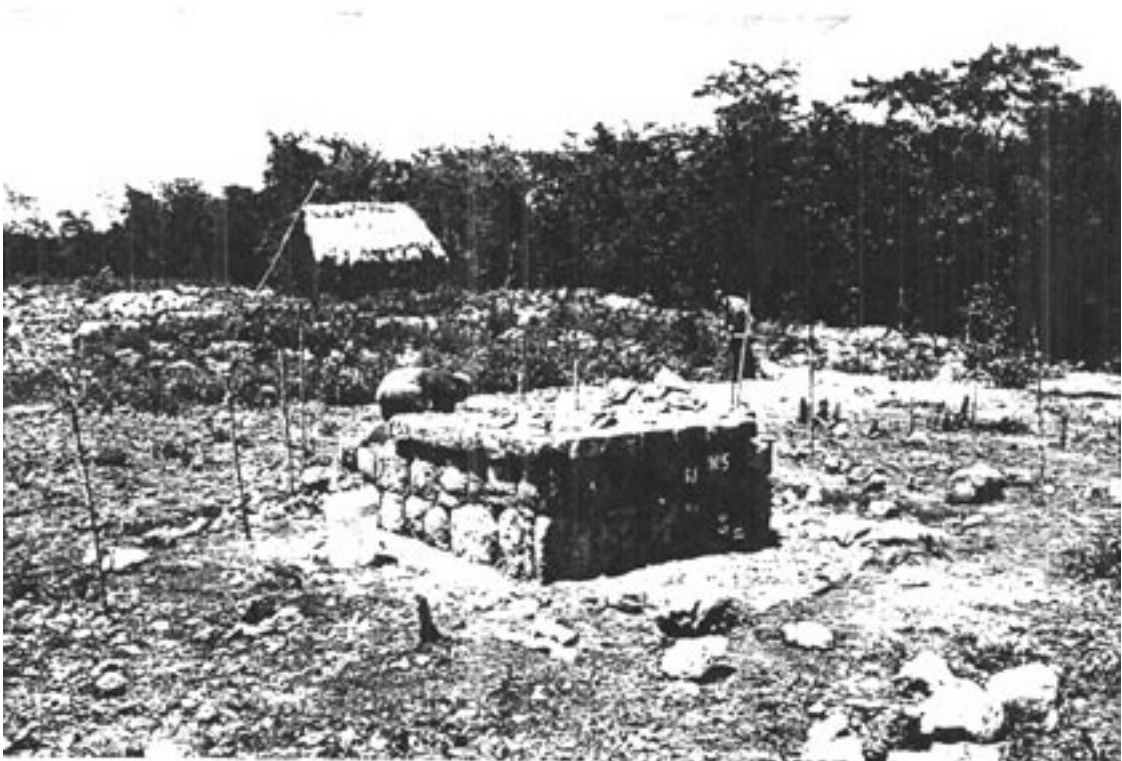
Figura 126. Restauración de la Estructura 2A22, ángulo sudoeste.
