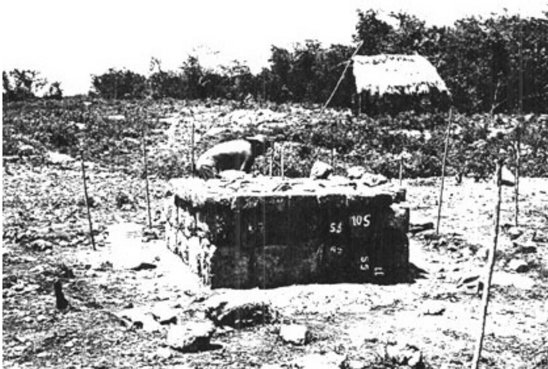
Figura 127. Restauración de la estructura 2A22, lado sur.
