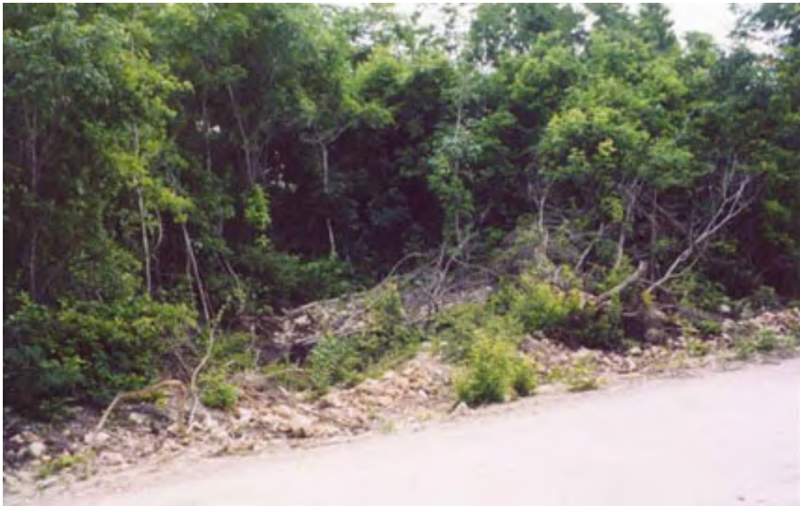
Figura 3b: Daños en la vía férrea – trabajos recientes con topadoras, que dañaron unos 7 km de lecho de vías. Las topadoras se utilizaron en un intento por ensanchar el moderno camino adyacente. Foto de Jennifer Mathews, 2002.
