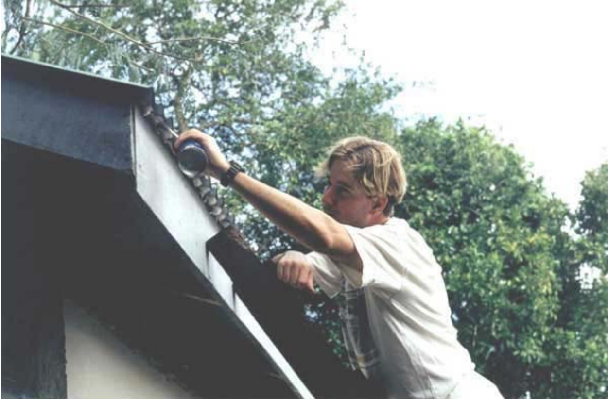
Figura A1:9. El becado en la tarea de aplicar espuma selladora expandible a los huecos creados por el techo metálico.
