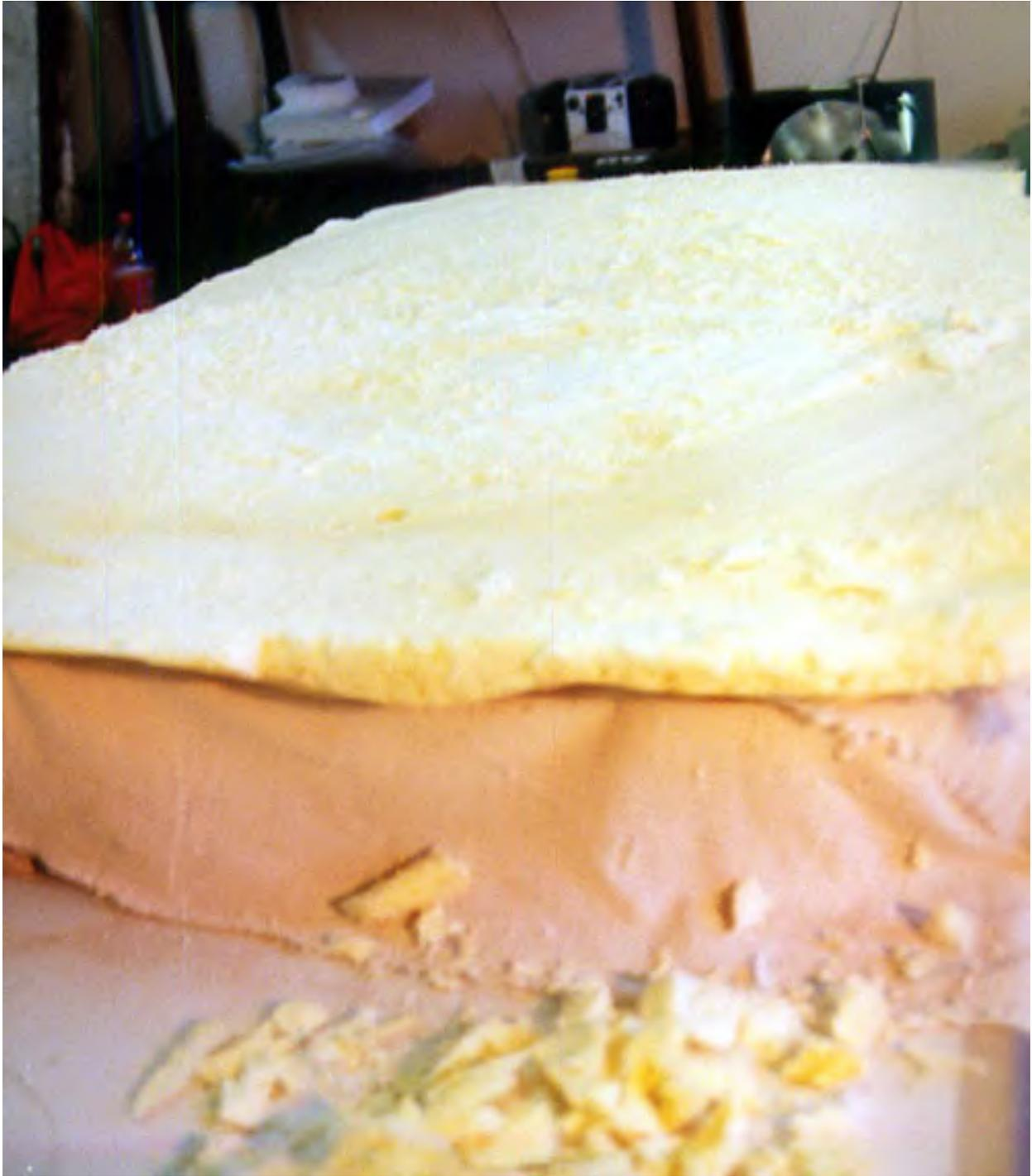
Foto 39. Capa de espuma de poliuretano usada para desprender el relieve adosado a la pilastra
