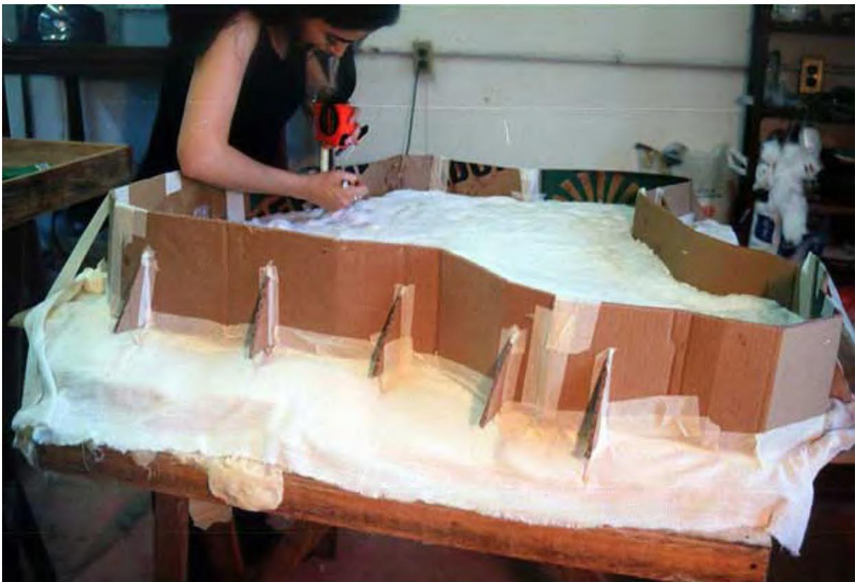
Foto 31. Colocación de táseles para contener el soporte provisional
