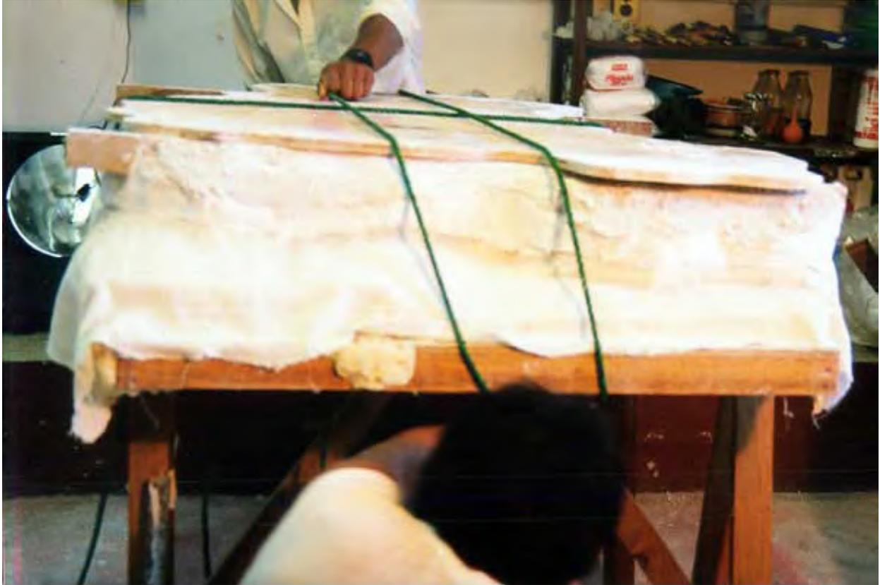
**Foto 35. Volteado del fragmento desprendido del muro**
