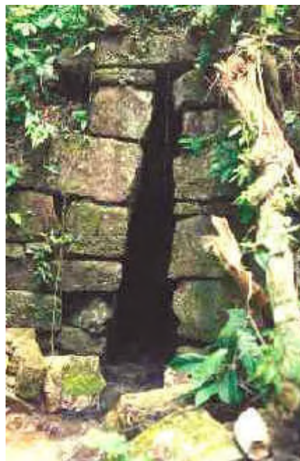
Figura 10 - Salida del acueducto Picota
