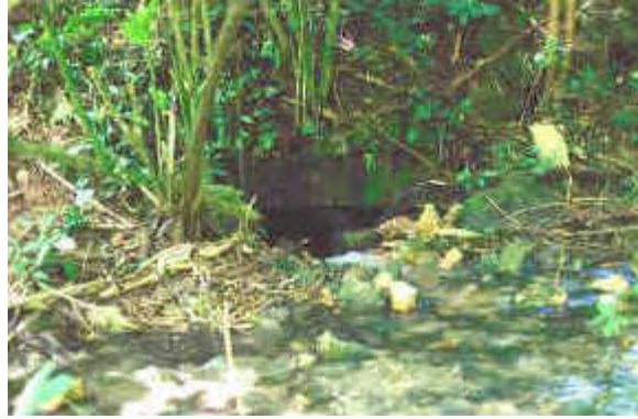
Figura 9 - Entrada al acueducto Picota
