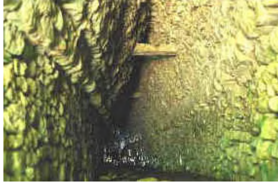
Figura 2 - Interior del acueducto Otulum
