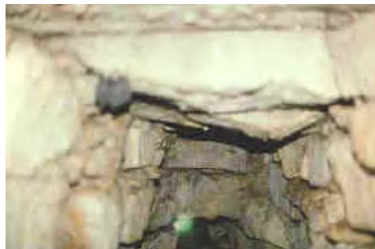
Figura 5 - Interior del acueducto Piedras Bolas
