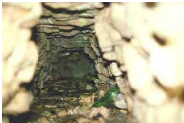
Figura 7 - Interior del acueducto Piedras Bolas
