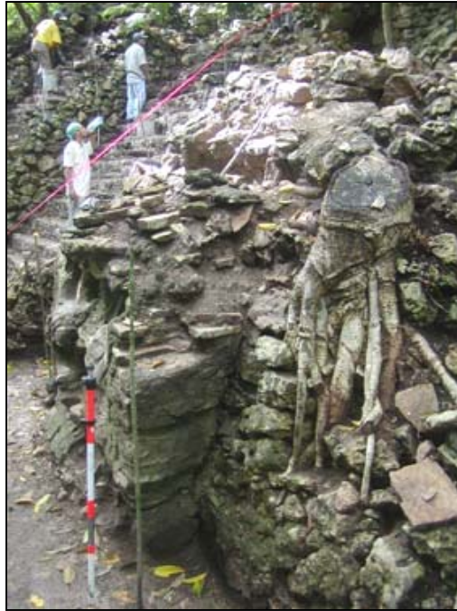
Figura 5. Restos y raíces de un árbol grande, que se han infiltrado en ambos los mascarones 1 y 2 (fotografía de la autora).
