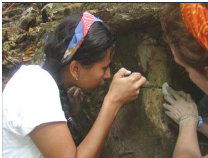
Figura 10. Griselda Pérez inyecta el aglutinante con una jeringa, mientras que Bass Rivera usa una pequeña esponja par prevenir que el pegamento se escurra por las grietas alrededor (fotografía tomada por Olivia Navarro Farr).
