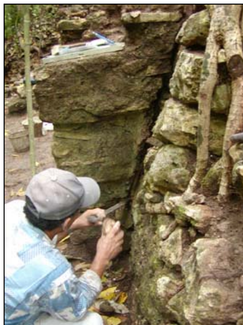
Figura 9. Ramos removiendo escombro suelto del vacío entre el Mascaron 1 y el muro que le da soporte, antes de su consolidación (fotografía de la autora).
