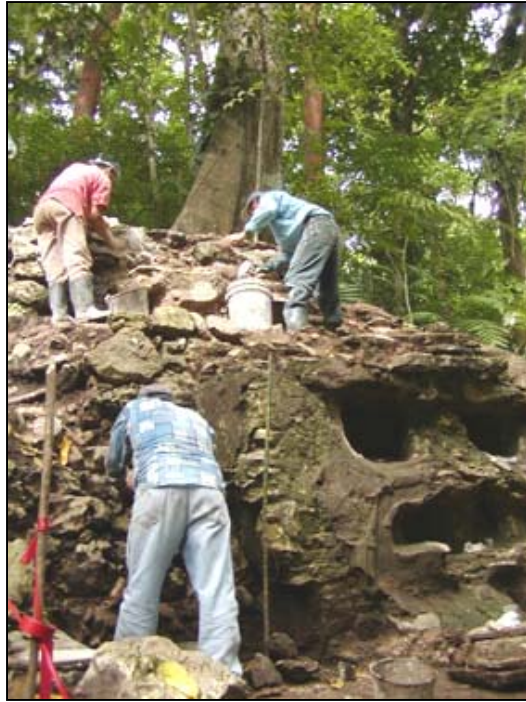
Figura 12. Ramos consolidando los vacíos en el Mascaron 1 (abajo) y a dos albañiles estabilizando la mampostería del muro que le daba soporte al Mascaron 2 (arriba) (fotografía tomada por la autora).
